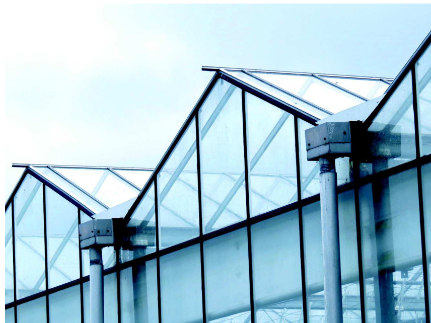
Figuur5: Waterkerende panelen op de kasdaken om water op de kas langer vast te houden
